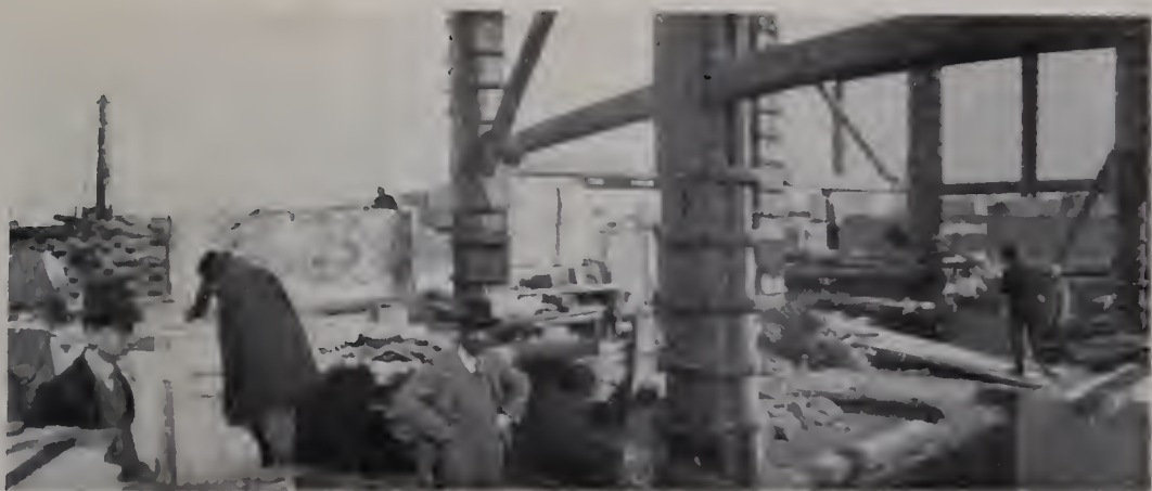
258. — Mentre procedono i lavori
